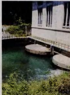
Το 2013-2014 κατασκευάστηκε το data center στον Λούρο, δίπλα στο υδροηλεκτρικό εργοστάσιο της ΔΕΗ, ώστε να λειτουργεί με ψύξη και από τον ποταμό – έργο πρωτοποριακό για την εποχή.
